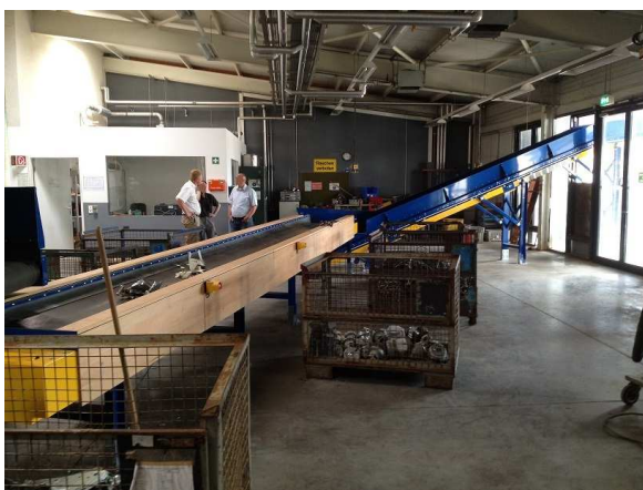
Sortierstrecke für 8 Personen und Abtransportband Restmaterial
